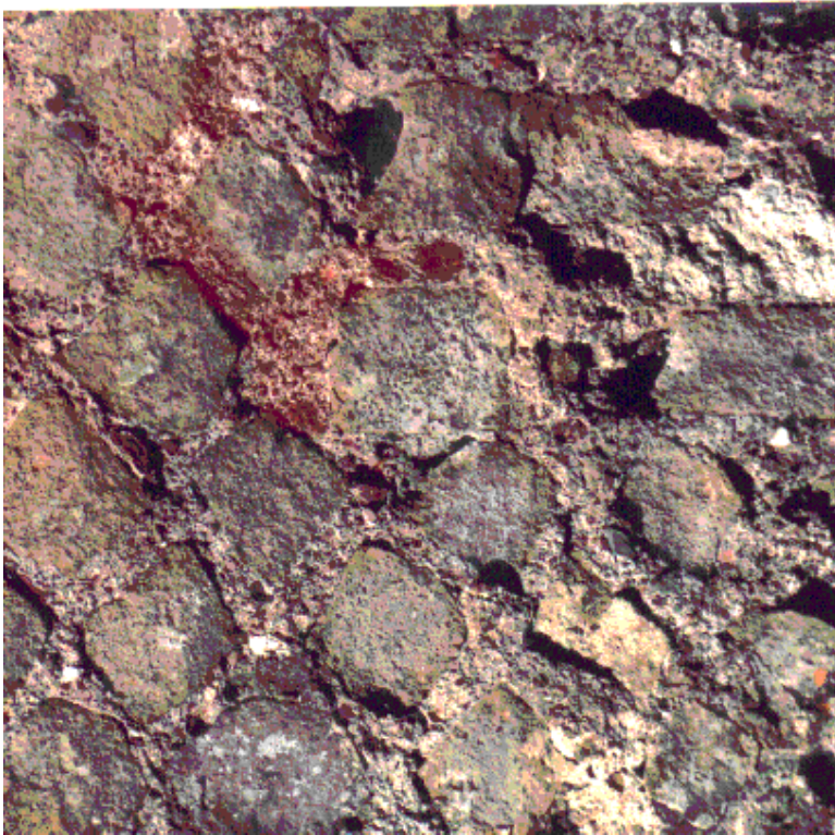
Figure 11: Villa Hadriana mortier contenant des agrégats volcaniques rouges
